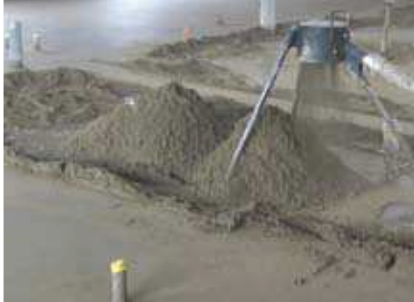
Le mortier de sol sur le chantier, prêt à être traité
